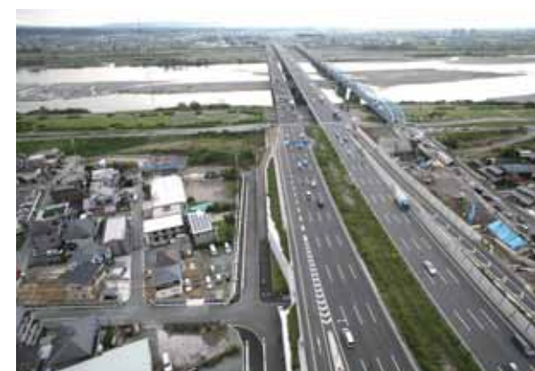
図 新天竜川橋(道路拡幅の例)
