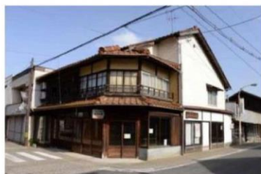
空き店舗を改修した創業支援施設 (鳥取県倉吉市)
